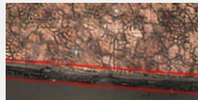
Corrosion Layer ~ 100µm
